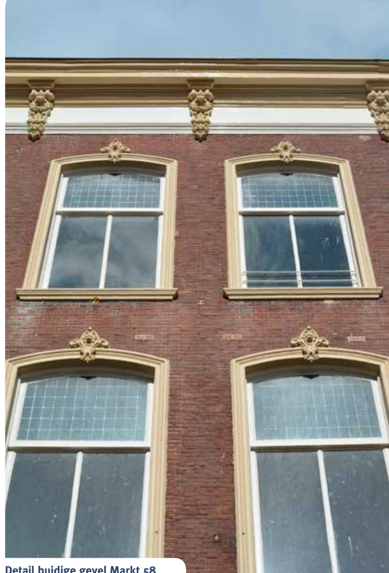
Detail huidige gevel Markt 58
