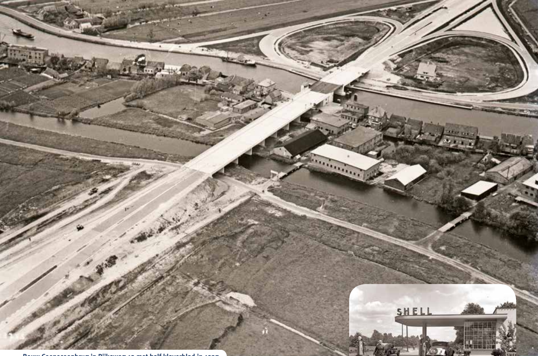
Bouw Coenecoopbrug in Rijksweg 12 met half klaverblad in 1937
