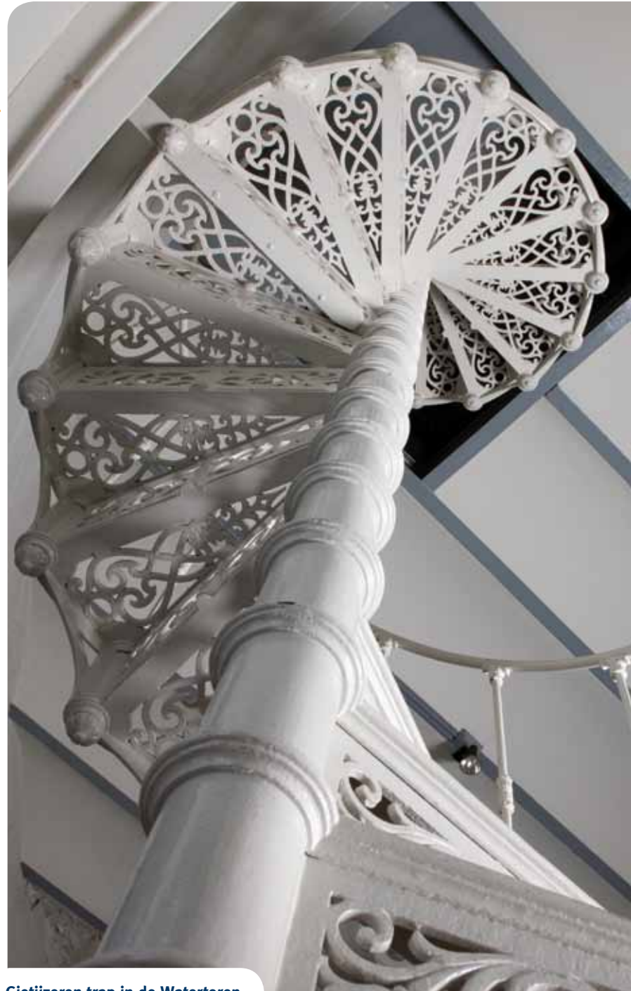
Gietijzeren trap in de Watertoren aan de Schielands Hoge Zeedijk. De 19e eeuw wordt ook wel de 'nieuwe ijzertijd' genoemd omdat ijzer veel werd toegepast voor decoratie en constructie (foto Iris Loonen)
