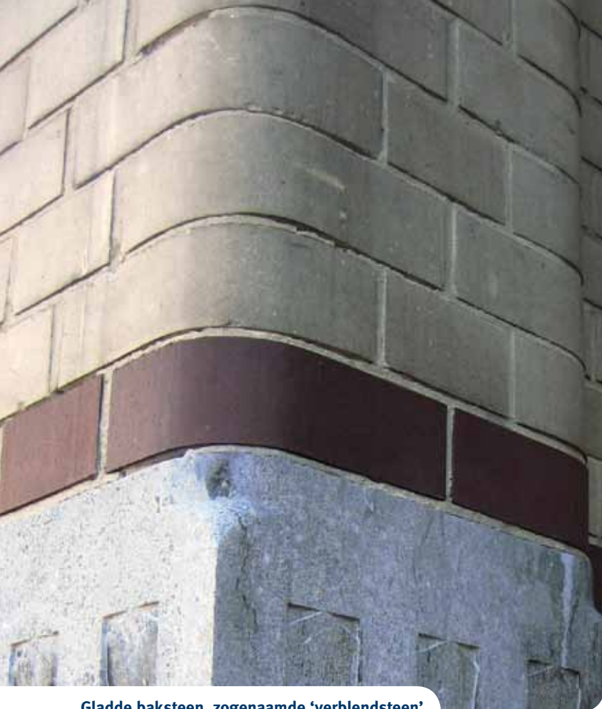
Gladde baksteen, zogenaamde ‘verblendsteen’ in het portaal van Oosthaven 5 (foto Marije Strating)
