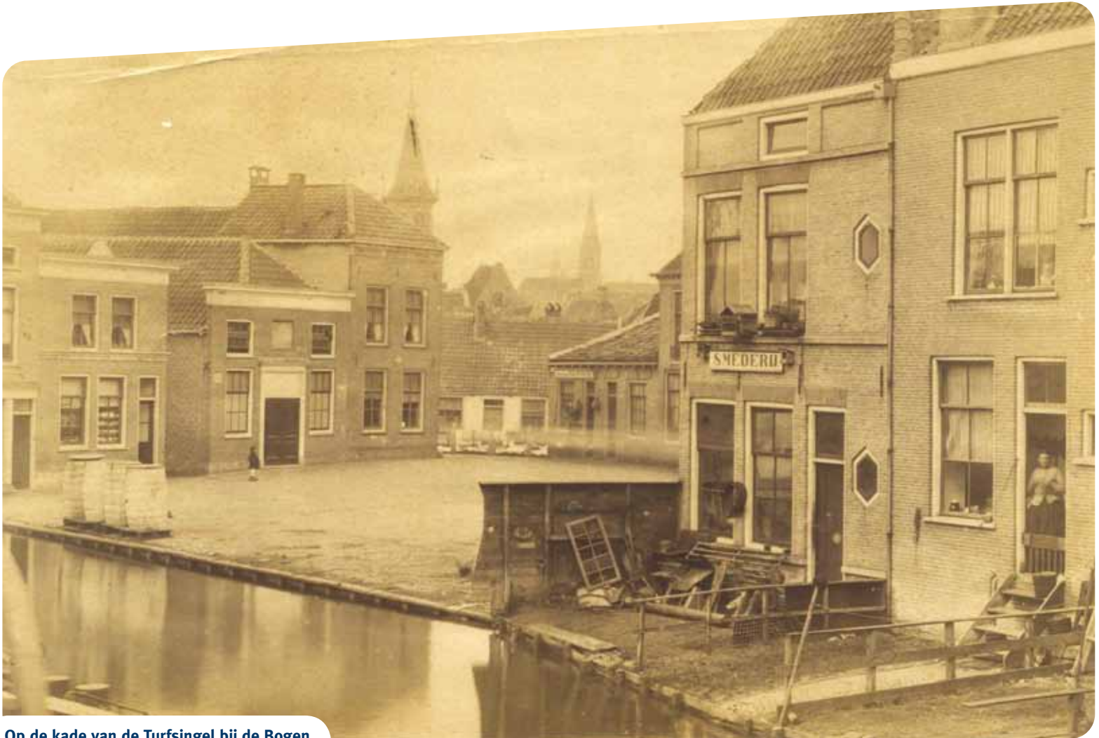
Op de kade van de Turfsingel bij de Bogen zijn in 1881 vier watertonnen te zien. Daarin wordt IJsselwater opgeslagen. Na zuivering dient dat als drinkwater. Na 1883 is dat niet meer nodig: dan krijgt Gouda een waterleidingnet (collectie Streekarchief Midden-Holland)
