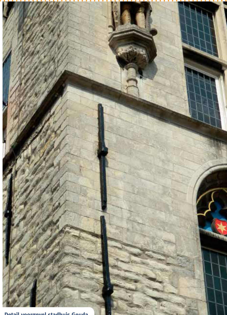
Detail voorgevel stadhuis Gouda.
