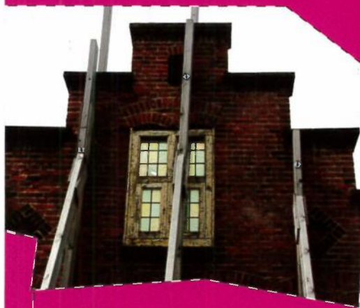
Detail restauratie voorgevel Plateelfabriek Zuid-Holland aan de Raam
