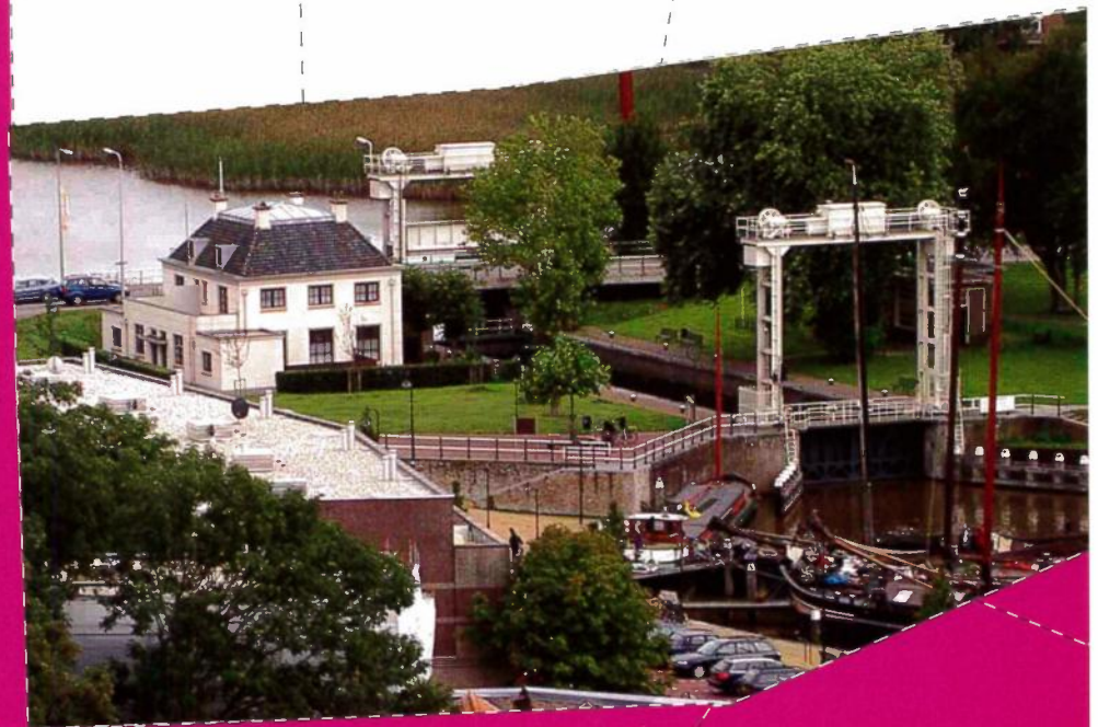
Zicht op de Mallegatsluis vanaf de Gouwekerk (foto Marjo van Loon)
